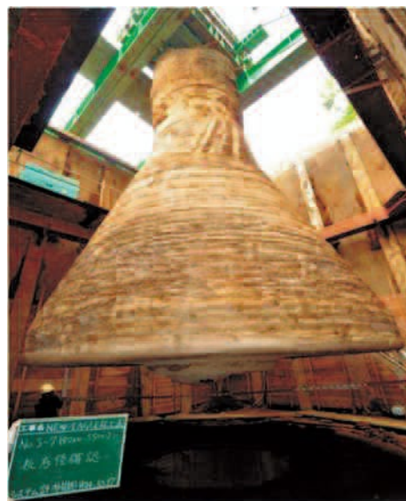
写真-1 掘り出したNEW-EAGLE杭
